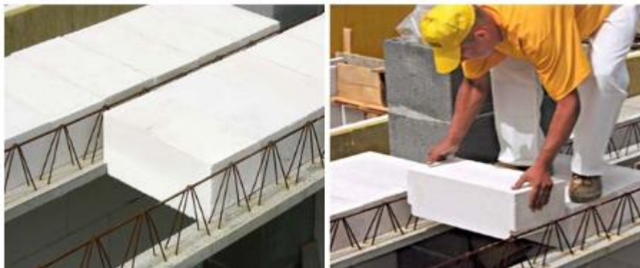
Рисунок 1– Використання T-блоків у збірно-монолітному перекритті
